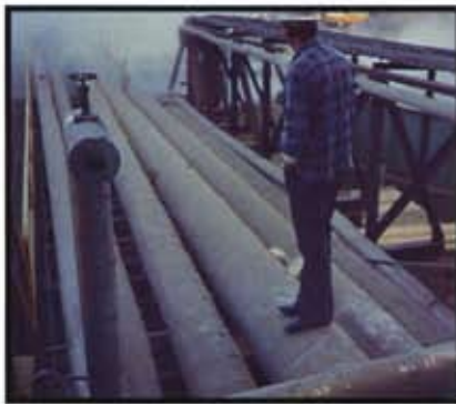
Pipeline de transport hydraulique de cendres combustibles pulvérisées (CCP), fabriqué à l'aide de tuyaux NASPipe .
