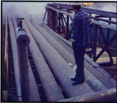
Tubería de transporte hidráulico hecha de NASPipe para ceniza pulverizada (residuo) de combustible.
